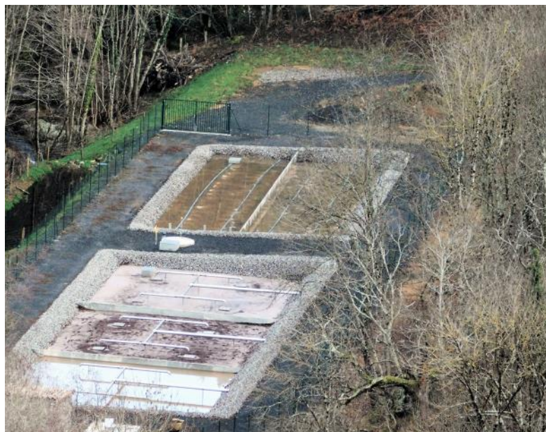
La station d'épuration est prête à fonctionner
